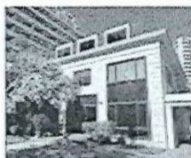
Fachada principal del edificio, acceso por La Gloria
