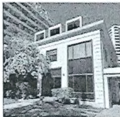
Fachada principal del edificio, acceso por La Gloria.
