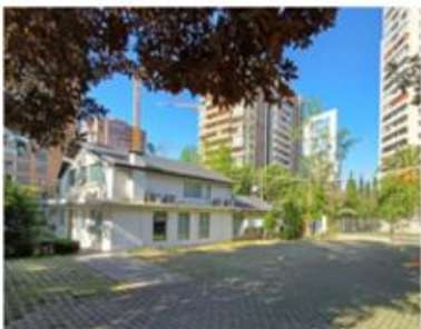
Edificio secundario y patio de estacionamientos
