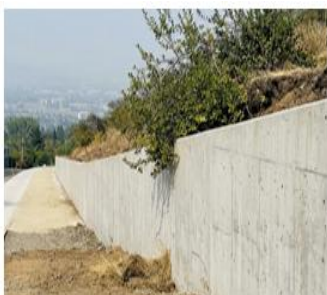
CONSTRUCCIÓN MURO DE CONTENCIÓN FALTANTE EN CAMINO EL OBSERVATORIO
