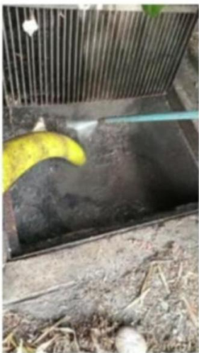
1. Río Claro (ducto obstruido por raíces 105 metros aproximadamente)
