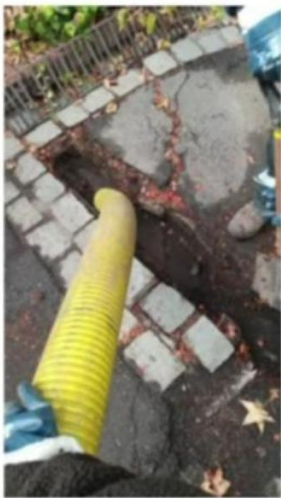
1. Río Claro (ducto obstruido por raíces 105 metros aproximadamente)
