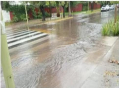
2. Alonso de Camargo (ducto bloqueado por raíces requiere nuevo colector 300 metros aproximadamente)
