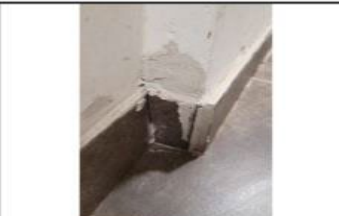
Cerámica sin terminación dpto 902
