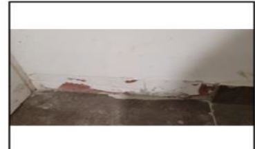
Cerámica sin terminación dpto 902
