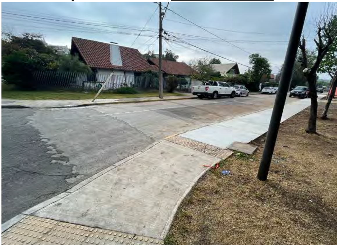
Figura 6-6. Catastro de Pavimentos, Cruce Christiensen con Hnos. Cabot .
