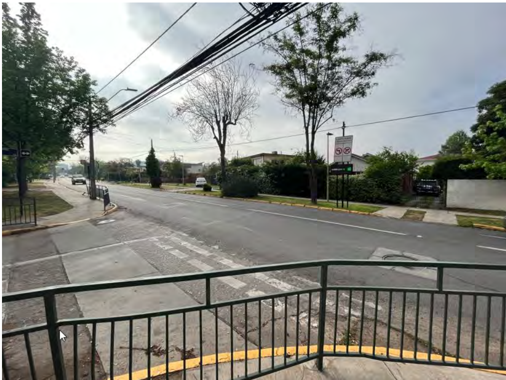
Figura 6-6. Catastro de Pavimentos, Cruce O'Carrol con Pdte. Riesco
