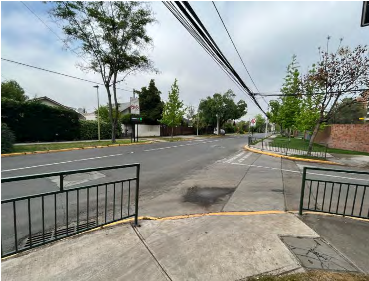
Figura 6-4. Catastro de Pavimentos, Cruce O'Carrol con Pdte. Riesco
