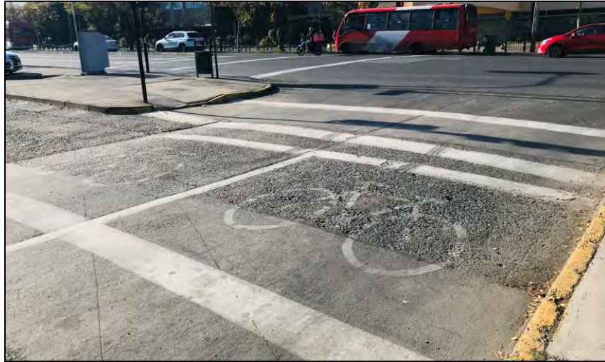
IMAGEN 42 LÍNEA DE DETENCIÓN PARA CICLOS.
