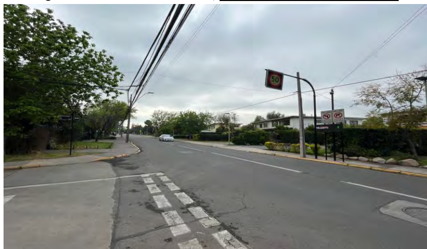
Figura 6-2. Catastro de Pavimentos, Cruce Christiensen con Pdte. Riesco
