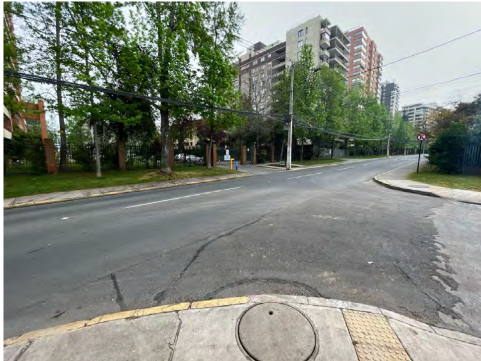
Figura 6-4. Catastro de Pavimentos, Cruce Christensen con Hnos. Cabot
