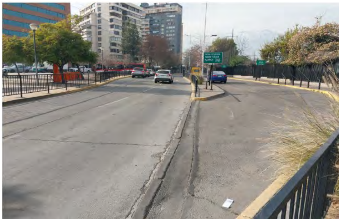
Av. Sebastián Piñera con Av. Apoquindo, Vista sur
