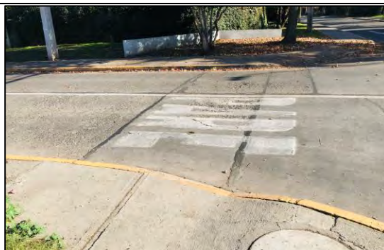
Intersección de Las Azaleas con Las Verbenas
