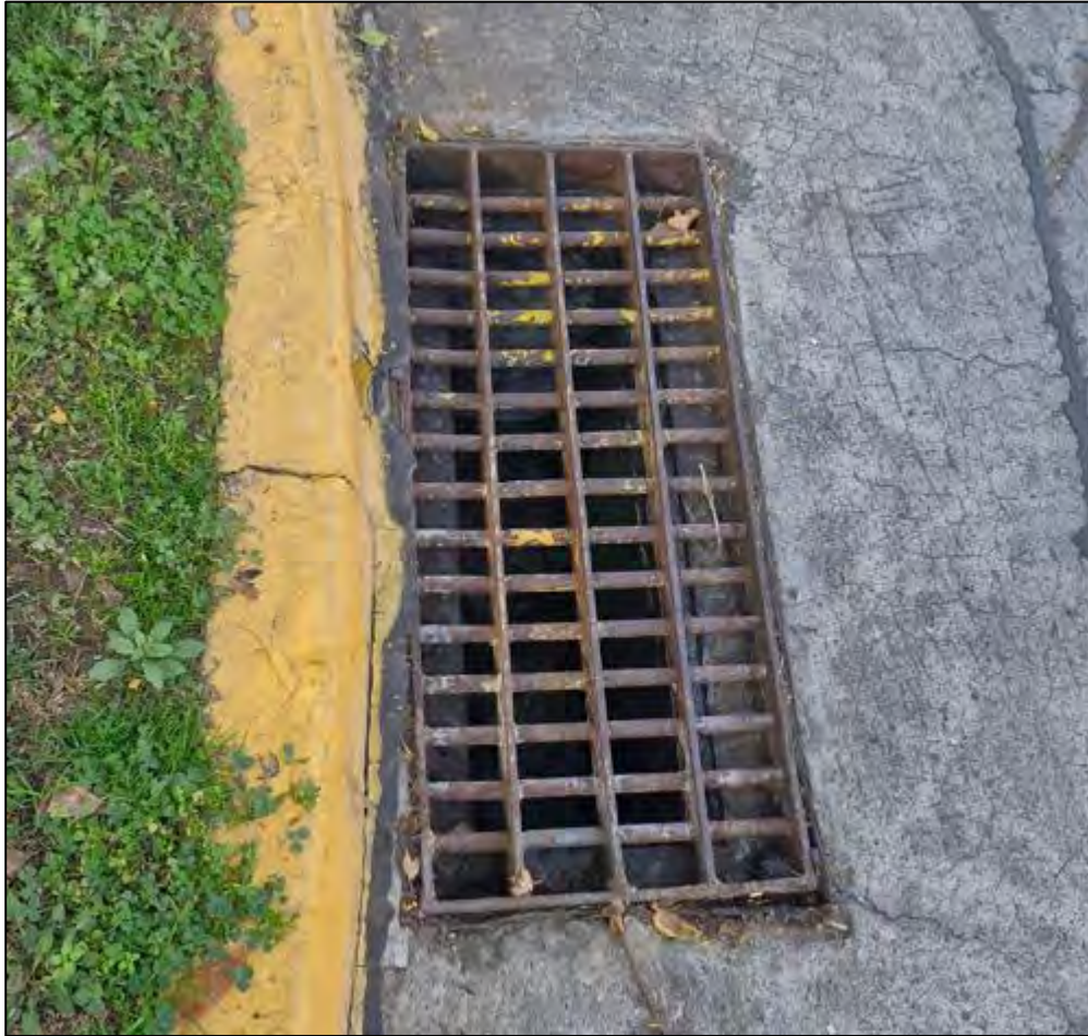
Sumidero (esquina nororiente de intersección con Robinson Crusoe)
