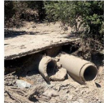
Recambio de tubos hidráulicos
